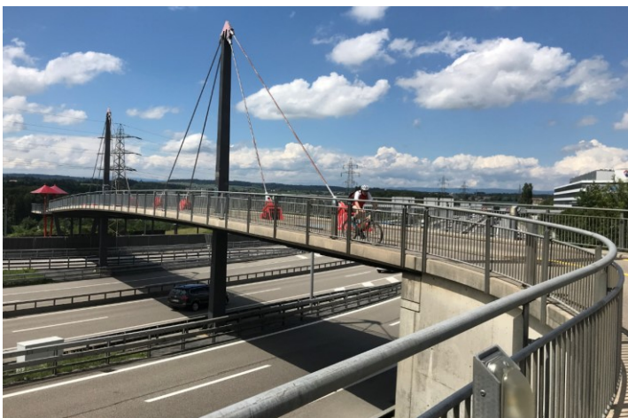
Abbildung 4: Velobrücke Wankdorf, Bern-Iltigen
