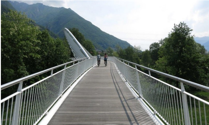
Abbildung 2: Fuss- und Veloverkehrsbrücke Monte Carasso – Bellinzona (TI)
